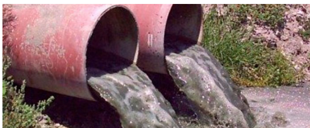
Figura 1.68. Aguas residuales no tratadas Fuente: Agua (2021)
